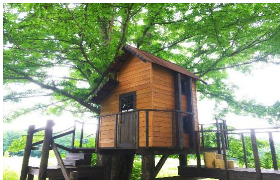
ツリーハウス外観
